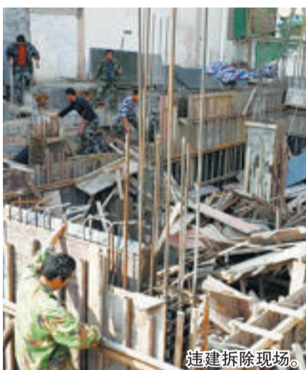
违建拆除现场。
