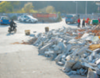
事发现场有一堆垃圾土头。
